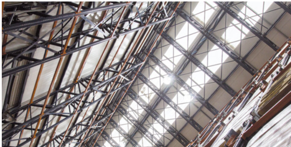
Imágenes de un almacén autoportante dedicado a almacenar productos a temperatura ambiente.
